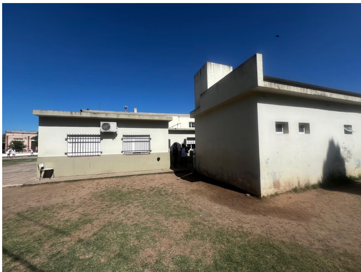
Exterior de bloque sanitario y área administrativa
